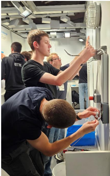
Installation einer Wechselschaltung
